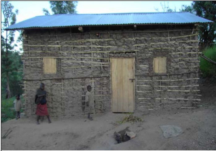
maison-type construite par les Amis (2006)
